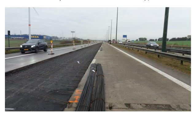
alors qu'environ 10.000 m² de réparations de béton armé continu étaient initialement prévues, ce sont finalement près de 25.000m² de béton armé continu qui doivent être traités. Ces dégradations conséquentes n'ont pu être détectées avant d'ouvrir la structure. Elles se situent sur le tronçon Weyler-Sterpenich (cf. ci-dessous).
